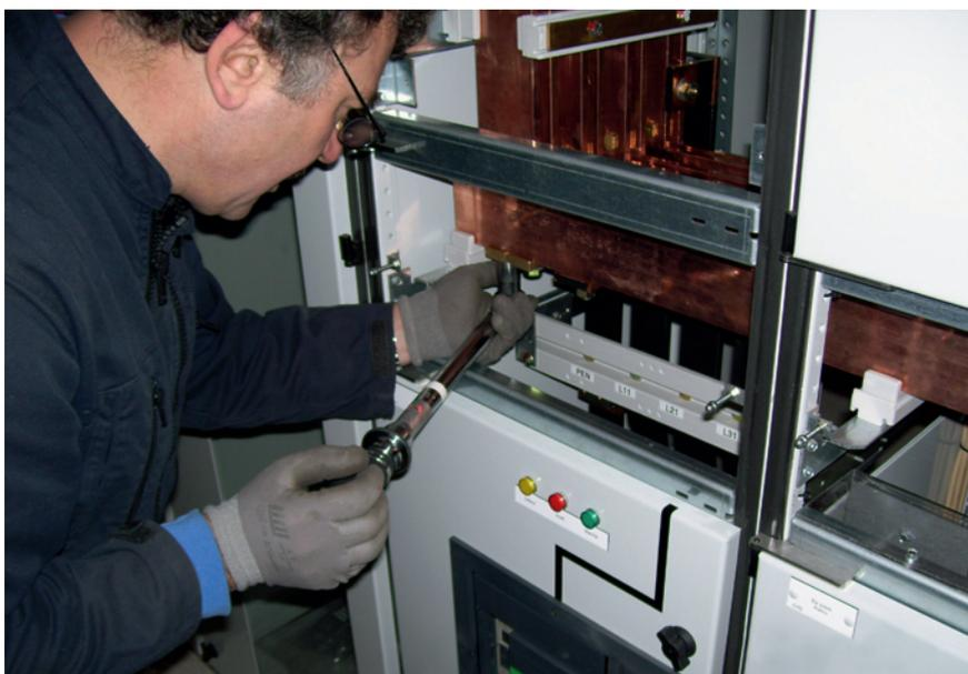
Assemblage mécanique d'un tableau
