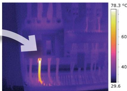
Mise en évidence de la surchauffe d'un câble dans un tableau
